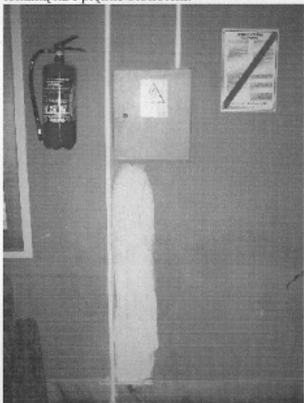
Foto nr3 - miejsce w którym został wymieniony przewód zasilający z RG rozdzielnicę lokalną na I piętrze biblioteki.
